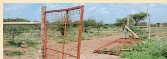
Durch Elefanten zerstörtes Tor einer Schule
