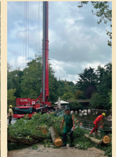
Direkt vor Ort wurden die abgetrennten Teile für die weitere Nutzung zerlegt
